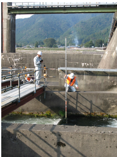
目視調査及び水位計測
