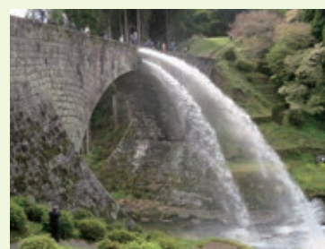
＜通潤橋（余水吐き時）＞
