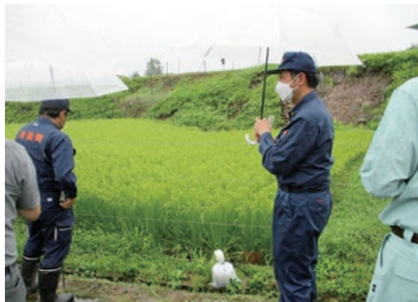
畦畔の崩壊があった水田の視察の様子 鍬江地区(胎内市)
