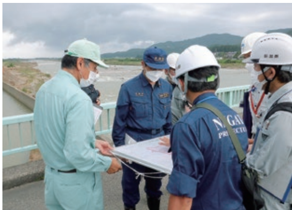
被災概要の説明の様子 荒川頭首工(村上市)
