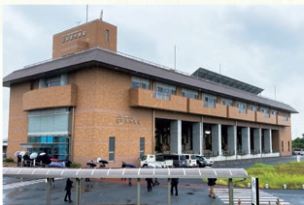
< 庄和排水機場（外観） >
