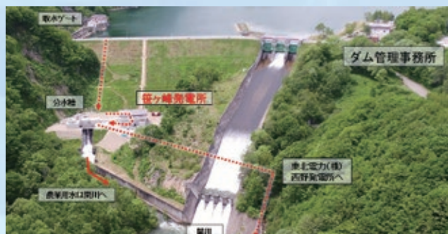
＜笹ヶ峰ダムの湖面からの有効落差（33.5m）を再生可能エネルギーに変換する笹ヶ峰発電所。発電能力は、年間約4,000MWhで、一般家庭のおよそ900戸分に相当する。＞
