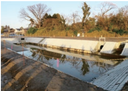
< 馬堀地区第2揚水機場の配水槽 >
