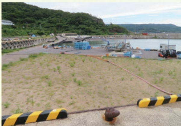
＜ 応急した物揚場 ＞
