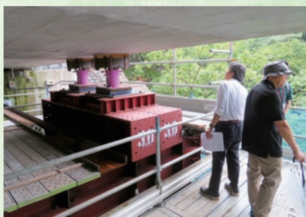
＜ 損傷した橋げたを支える仮設材 ＞
